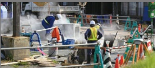
土木・工事現場
